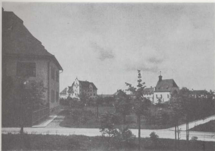
Blick zum Verwaltungsgebäude
